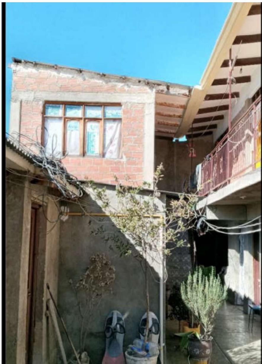
CONSTRUCCION NUEVA DE DOS PLANTAS, CON LADRILLO DE 6H (HUECOS) Y LADRILLO VISTO, CON REV. INTERIOR TERMINADO.
